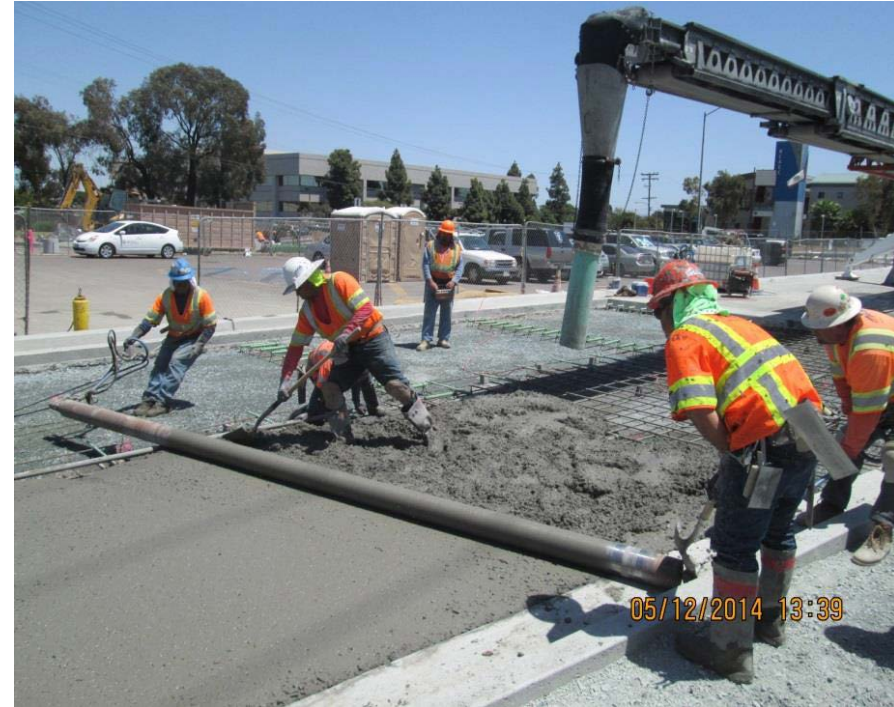
Concrete Pour for Bus Transit Lanes
