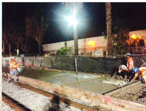
Pouring WB Subslab
